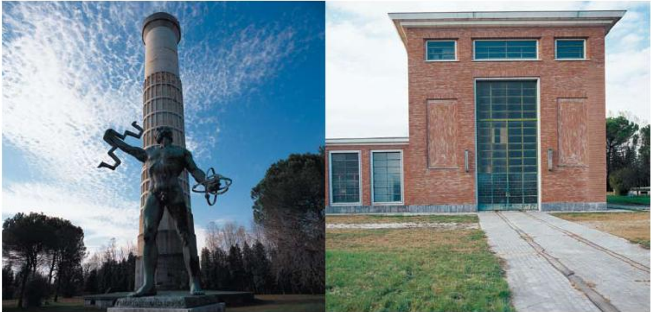
La torre piezometrica e il fabbricato centrale
