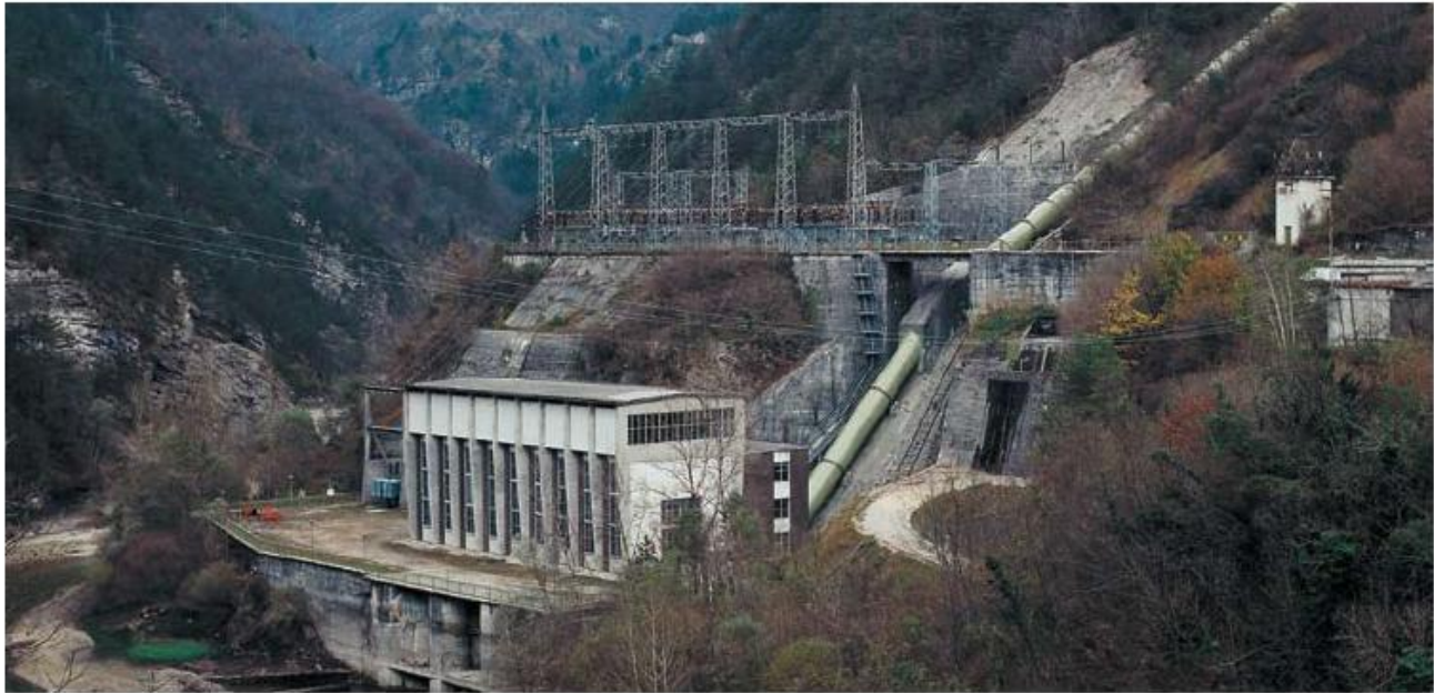
Il fabbricato centrale
