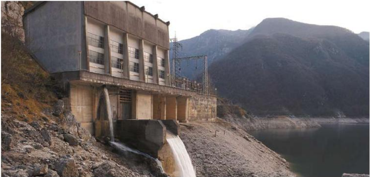
Il fabbricato Centrale
