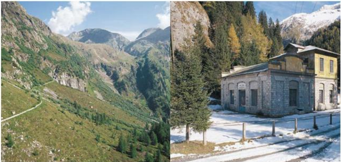
Il canale di gronda e il fabbricato centrale
