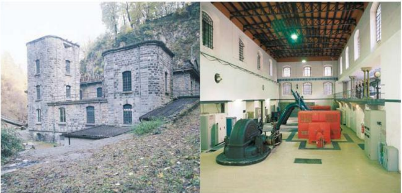
La centrale di Caffaro 1 e la sala macchine
