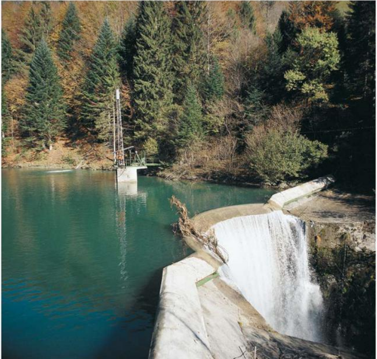
Diga di Dazarè
