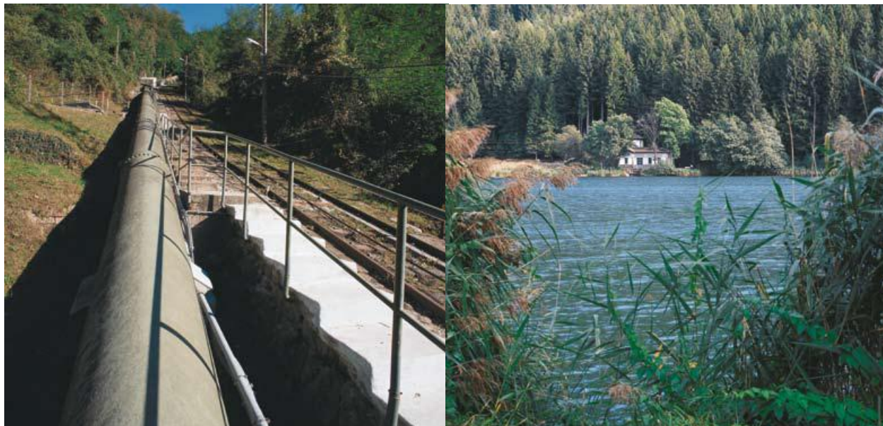
La condotta forzata e la stazione di pompaggio del Lago di Serraià
