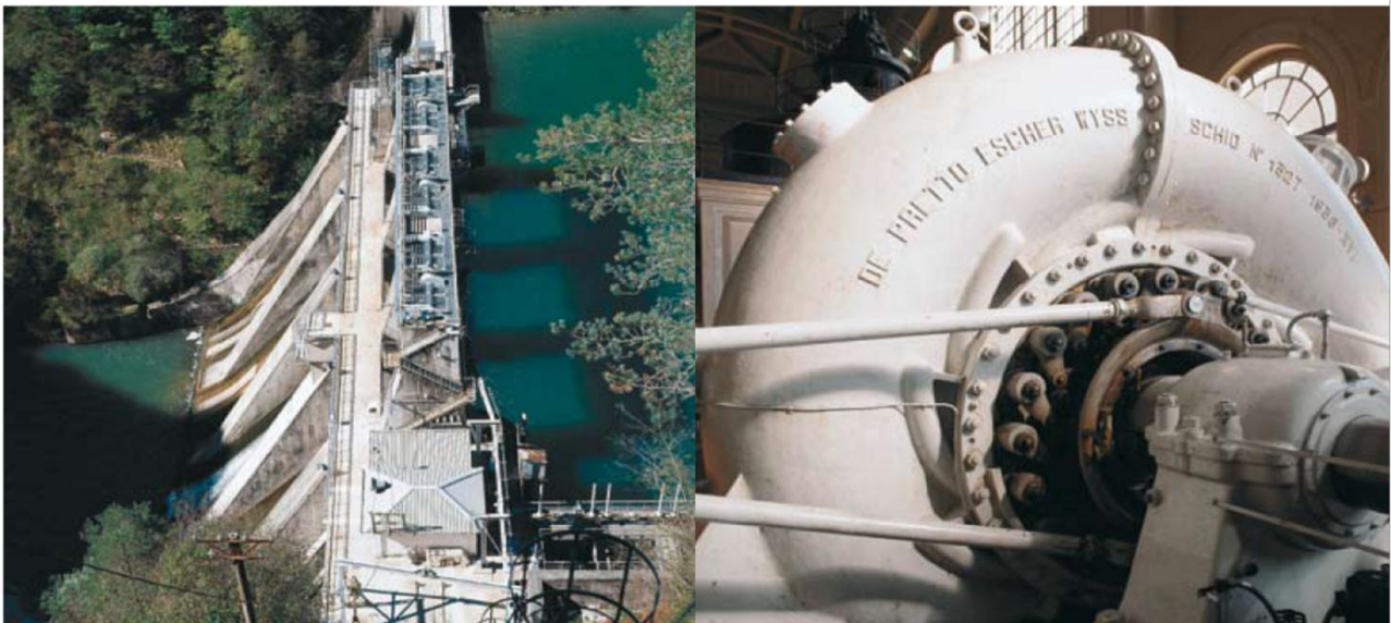
La diga di Mollaro e un particolare della turbina del gruppo 4
