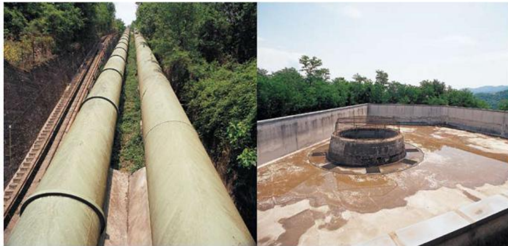
La condotta forzata e la bocca di presa
