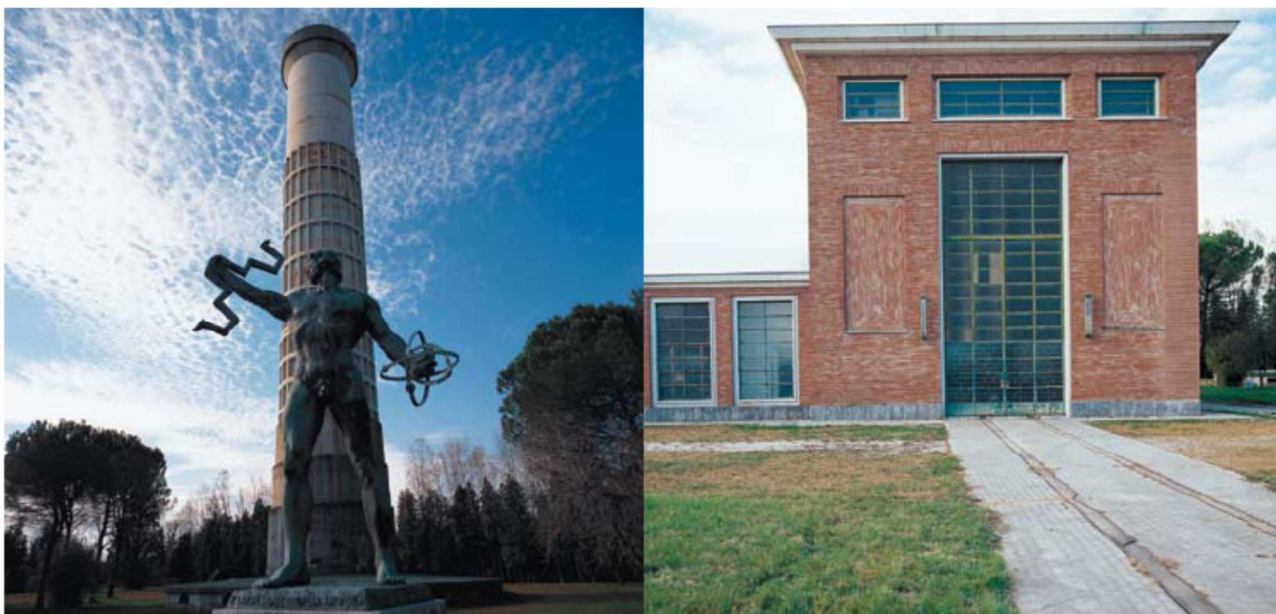
La Torre piezometrica e il fabbricato centrale
