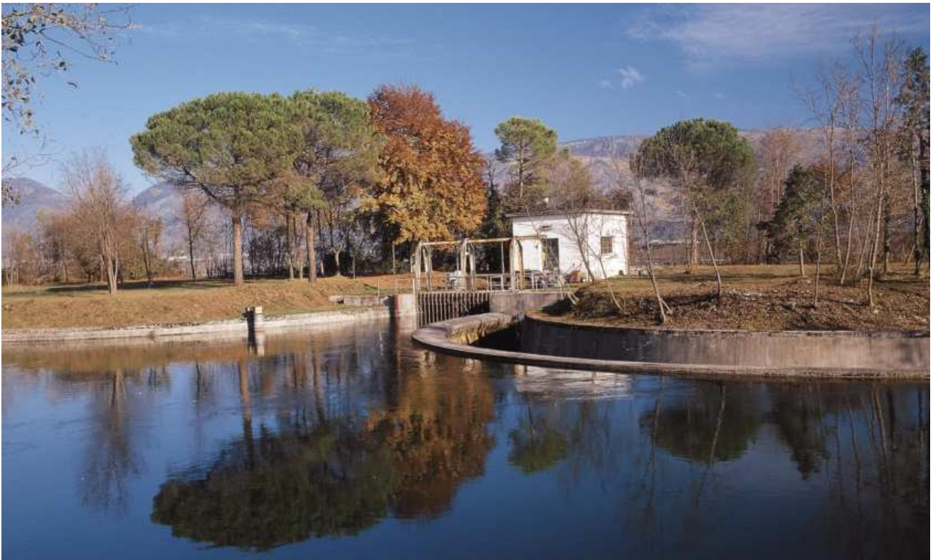
Opera di presa di Colle
