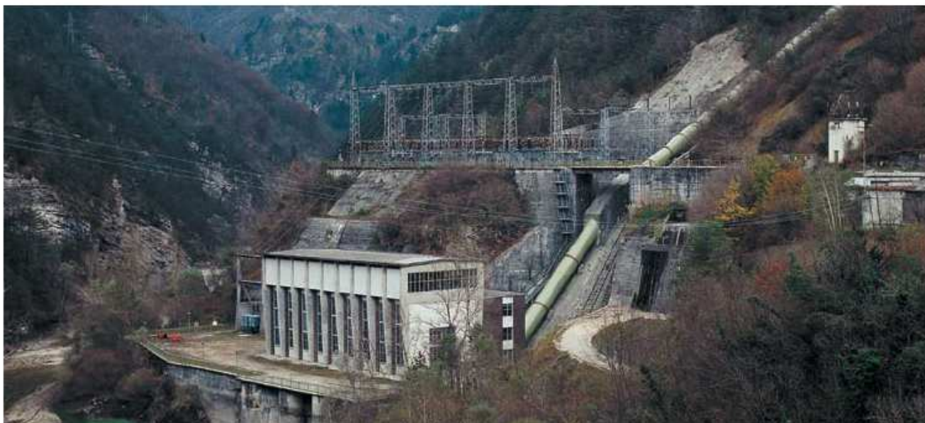
Il fabbricato centrale
