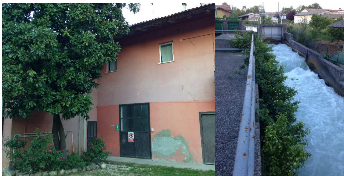
Ingresso della centrale e canale di scarico
