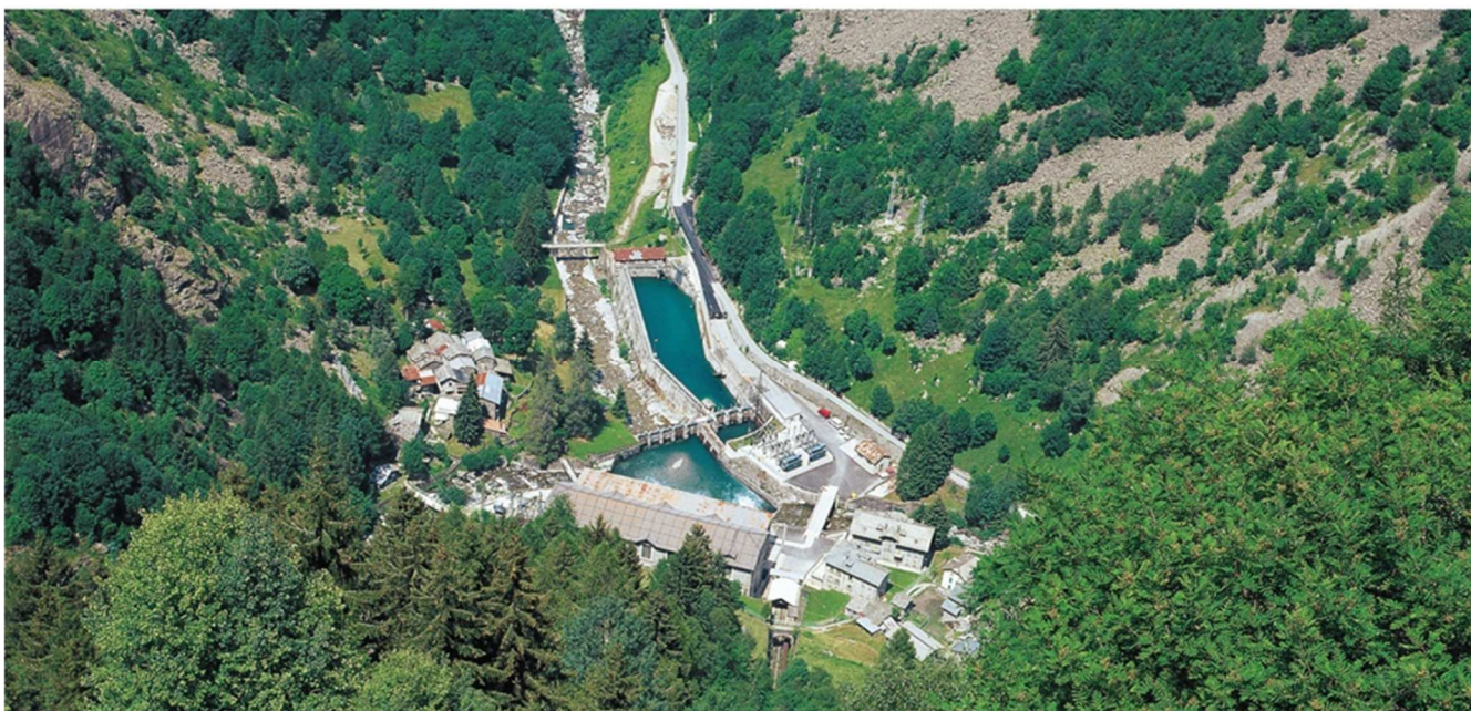
Panoramica dell'impianto di Vedello
