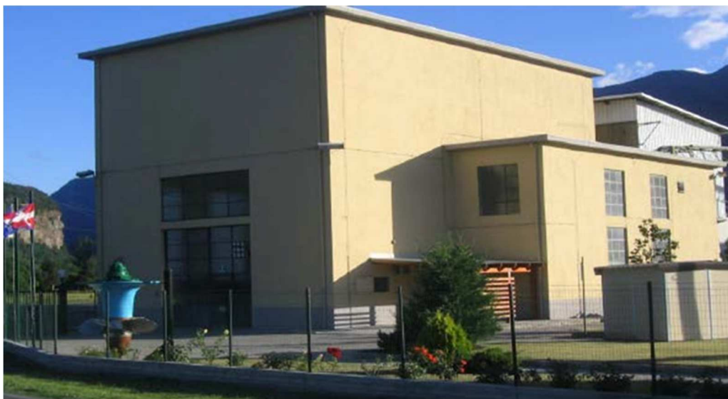
Edificio della centrale
