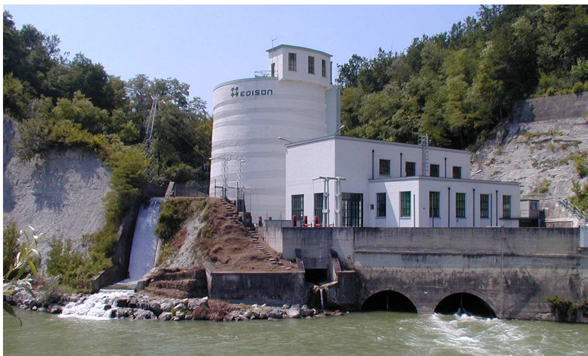
Impianto di Farigliano
