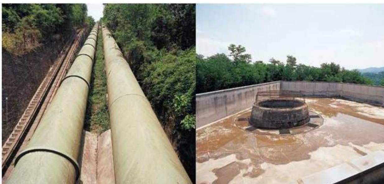
Impianto di Teglia
