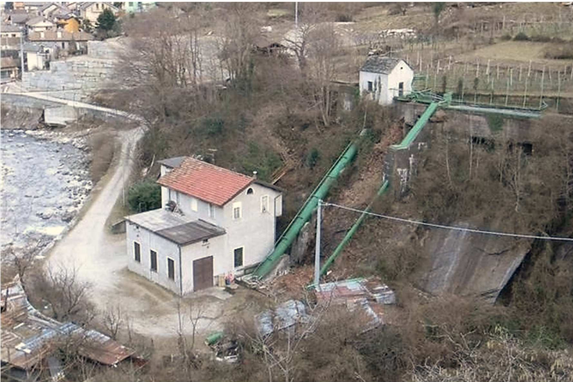
Edificio centrale impianto di Gaggiolo
