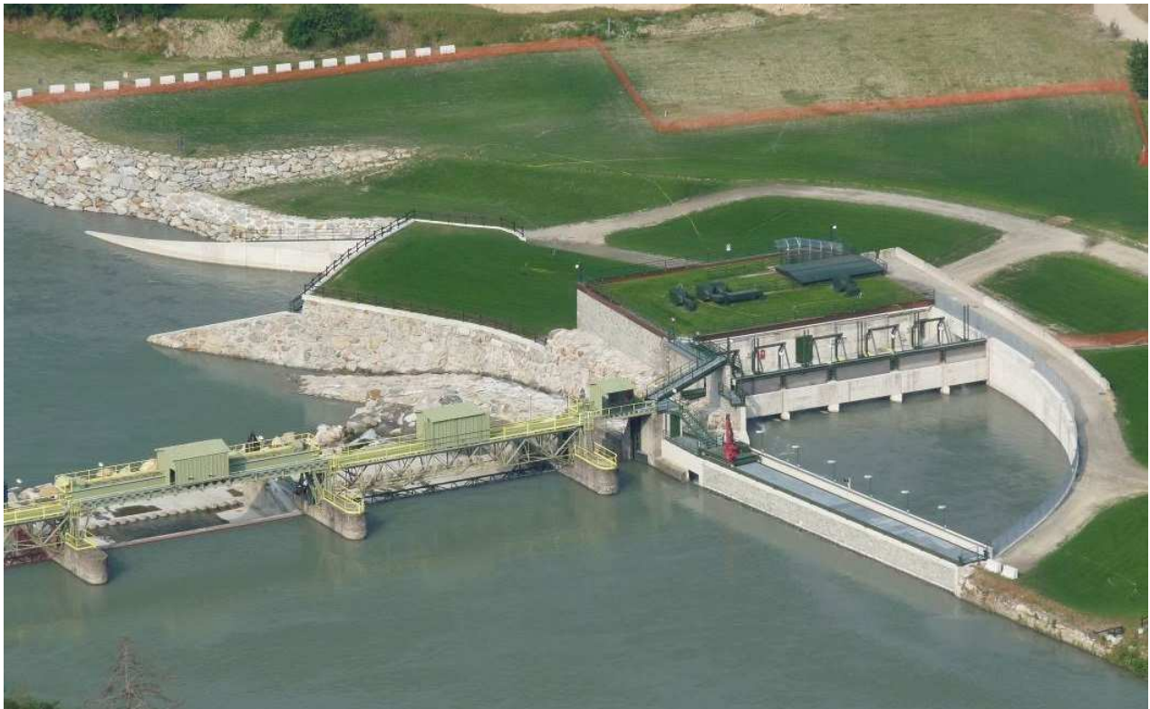
Impianto di Tavagnasco (Montestrutto)
