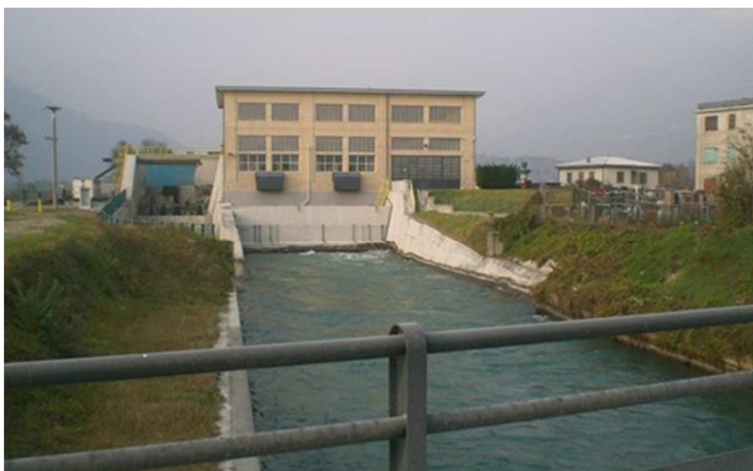
Edificio della centrale
