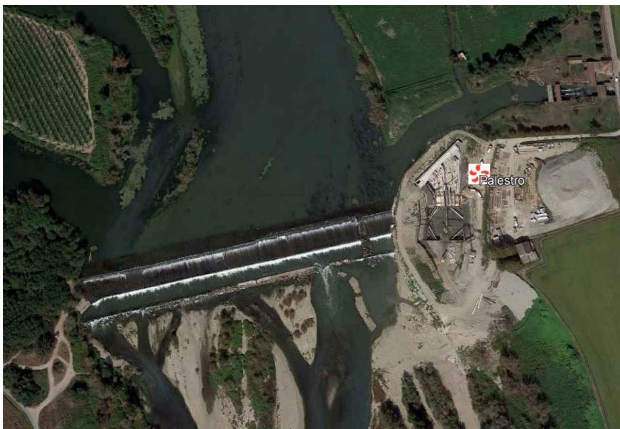
Impianto di Palestro (fonte: Google Earth)
