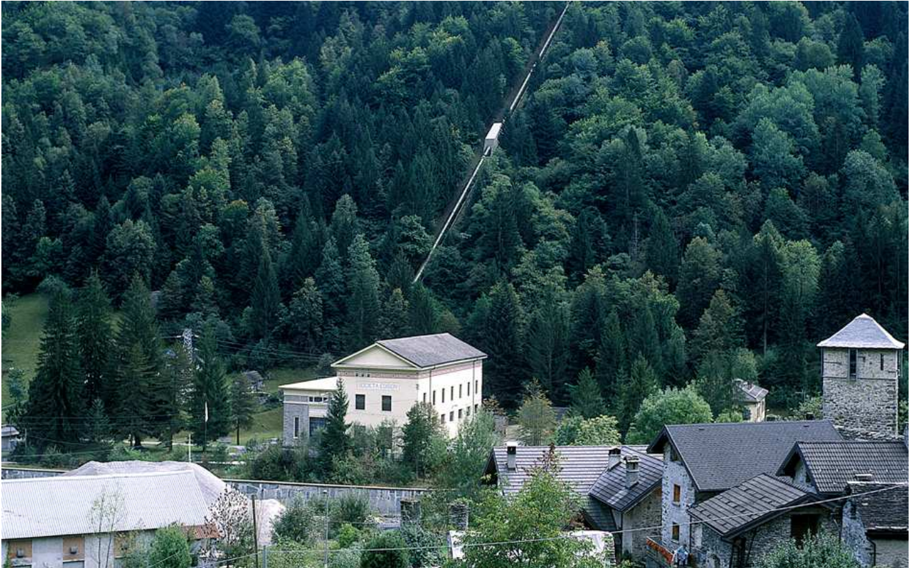
Centrale idroelettrica di Battiglio
