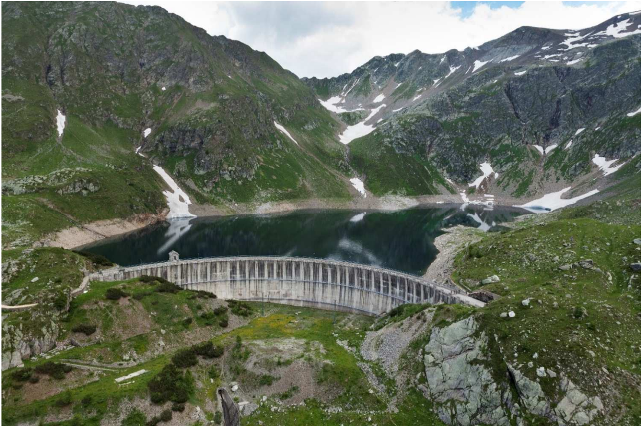
Diga di Publino e bacino della centrale Publino
