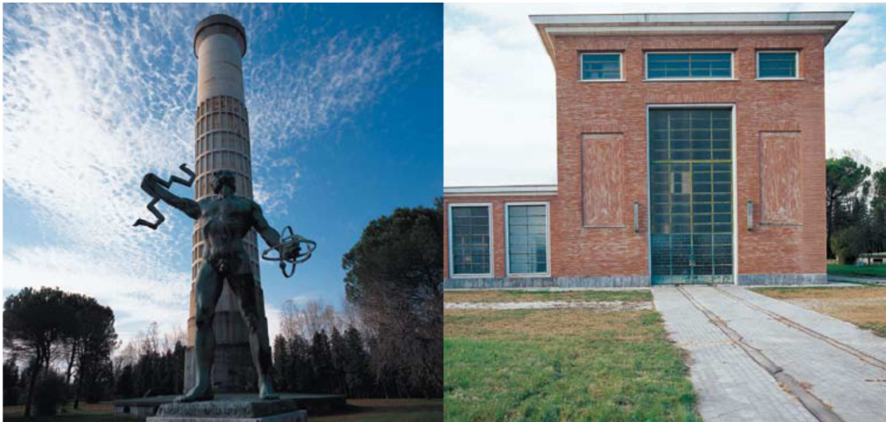
Torre piezometrica e il fabbricato centrale
