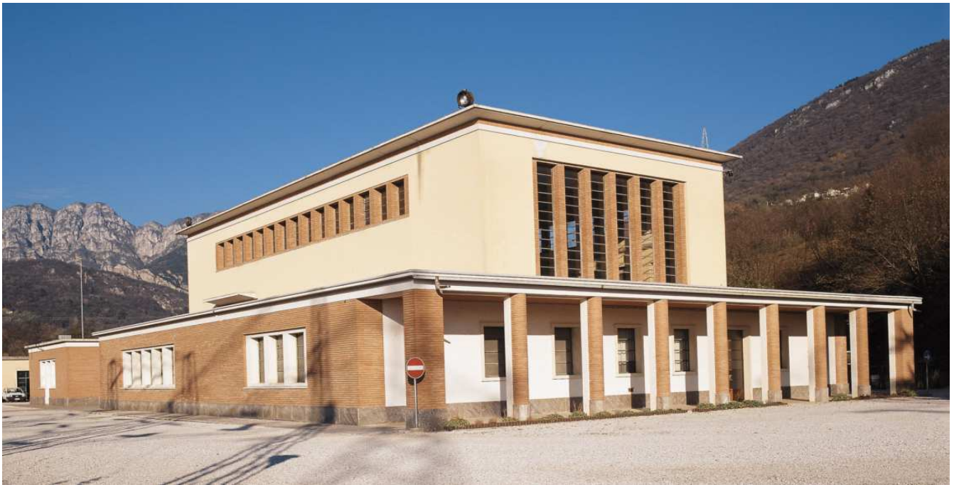
Impianto di Meduno
