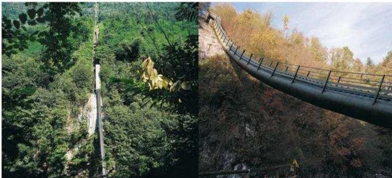
La condotta forzata e un particolare del profilo parabolico della stessa
