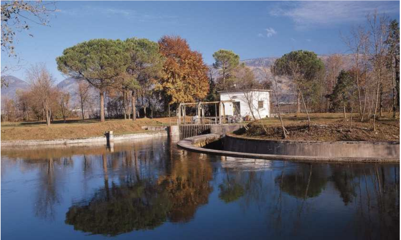
Opera di presa di Colle
