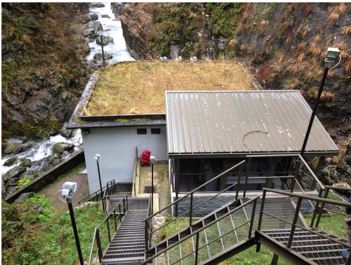
L'impianto di Fontanamora
