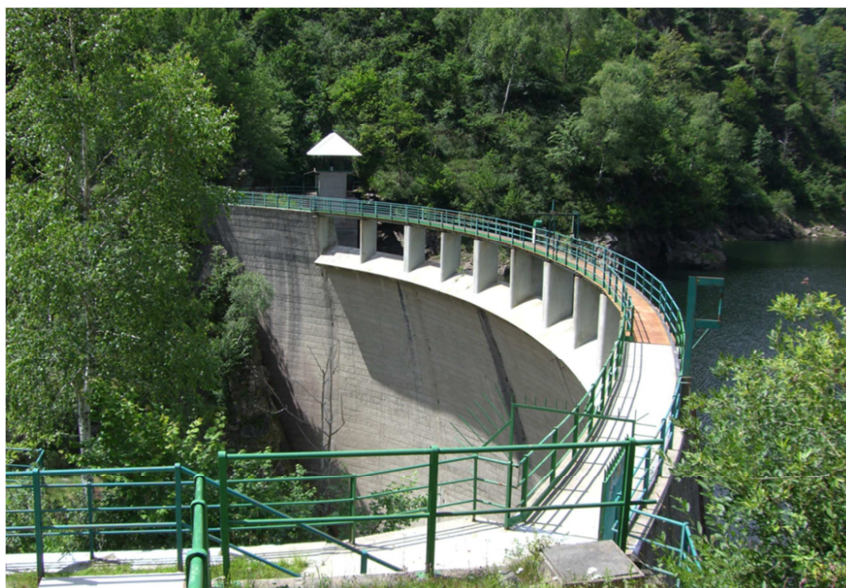
Diga delle Mische
