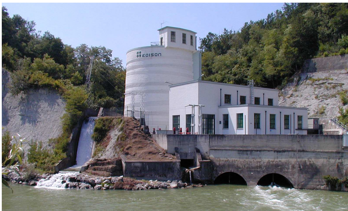
Impianto di Farigliano
