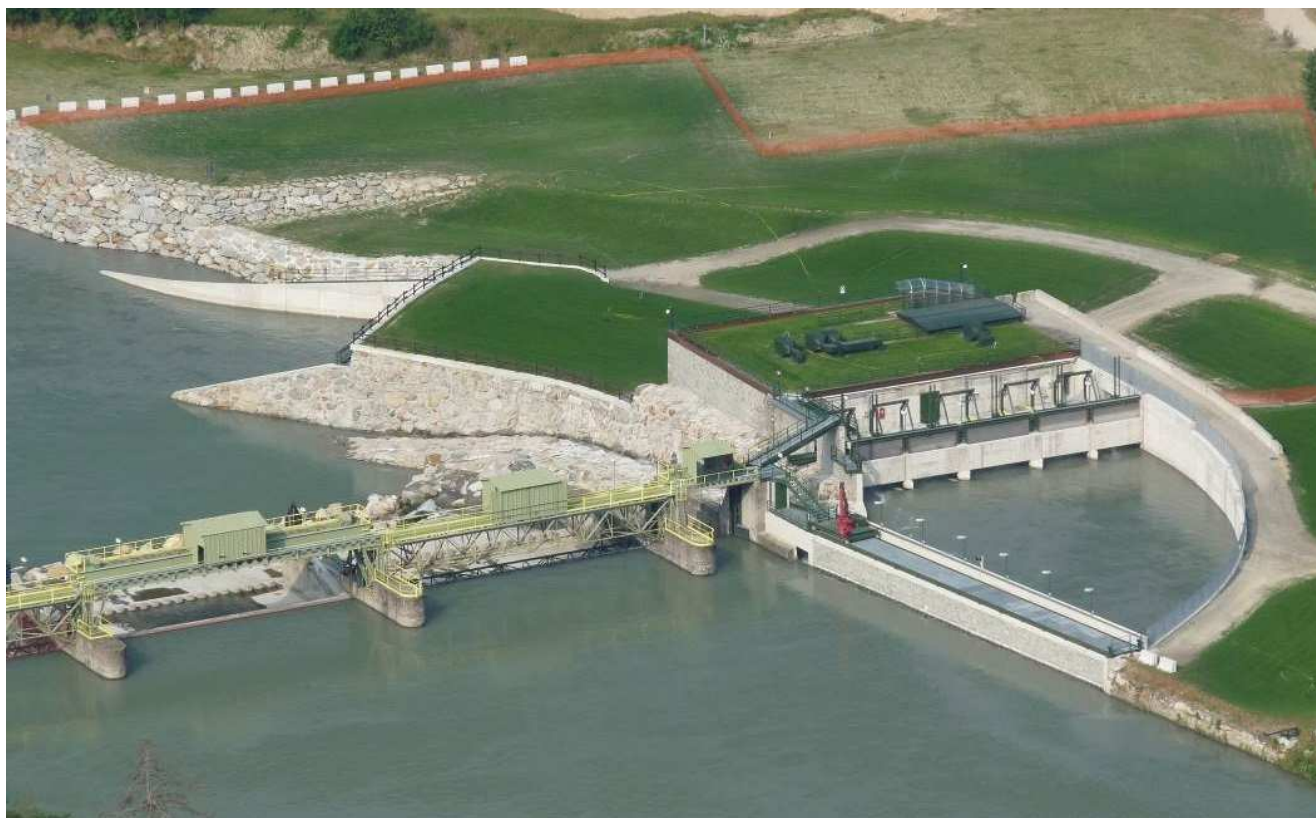
Impianto di Tavagnasco (Montestrutto)
