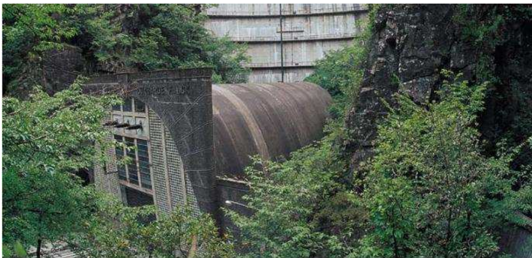
Impianto di Rocchetta
