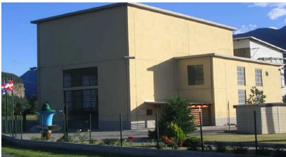
Edificio della centrale
