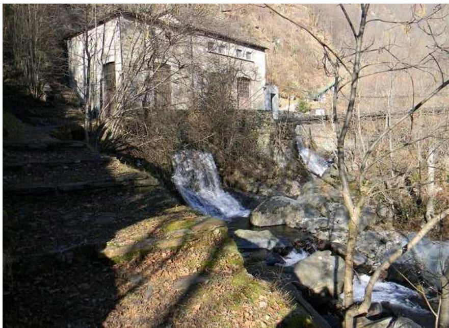
Canale di consegna impianto di Montescheno
