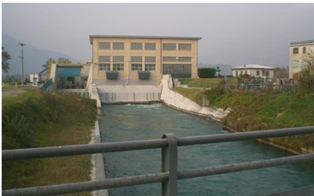
Edificio della centrale
