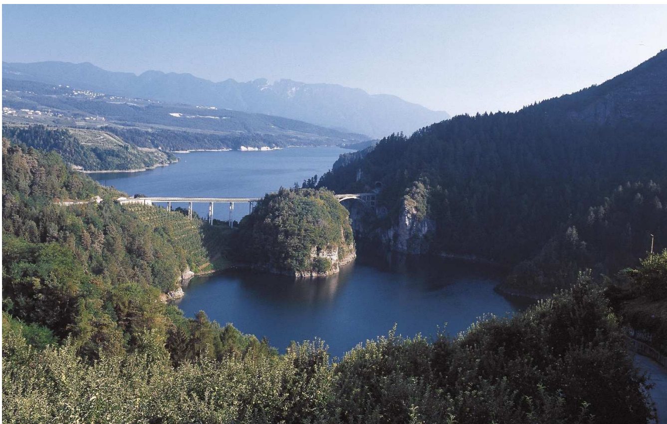
La diga di S. Giustina e il serbatoio artificiale
