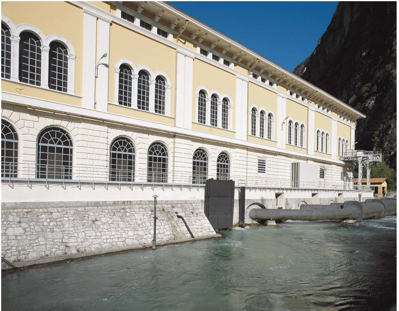
Impianto di Mezzocorona
