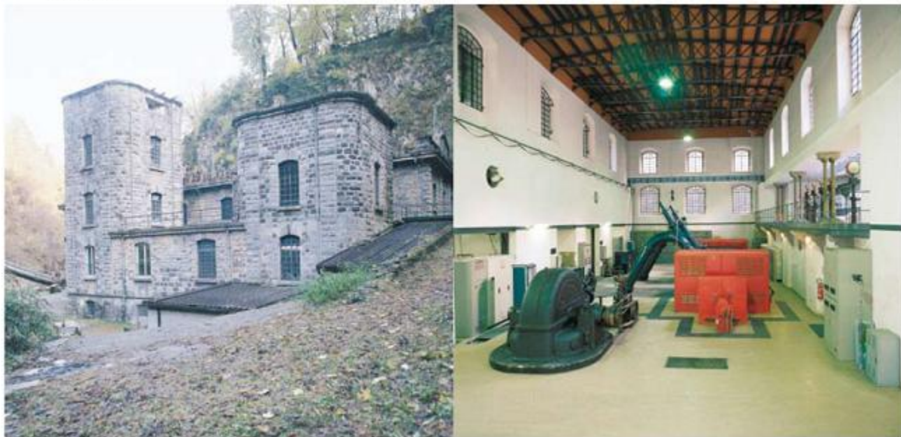
La centrale di Caffaro 1 e la sala macchine
