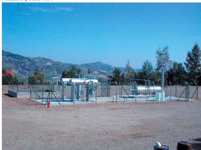
Piazzale pozzo AC4
