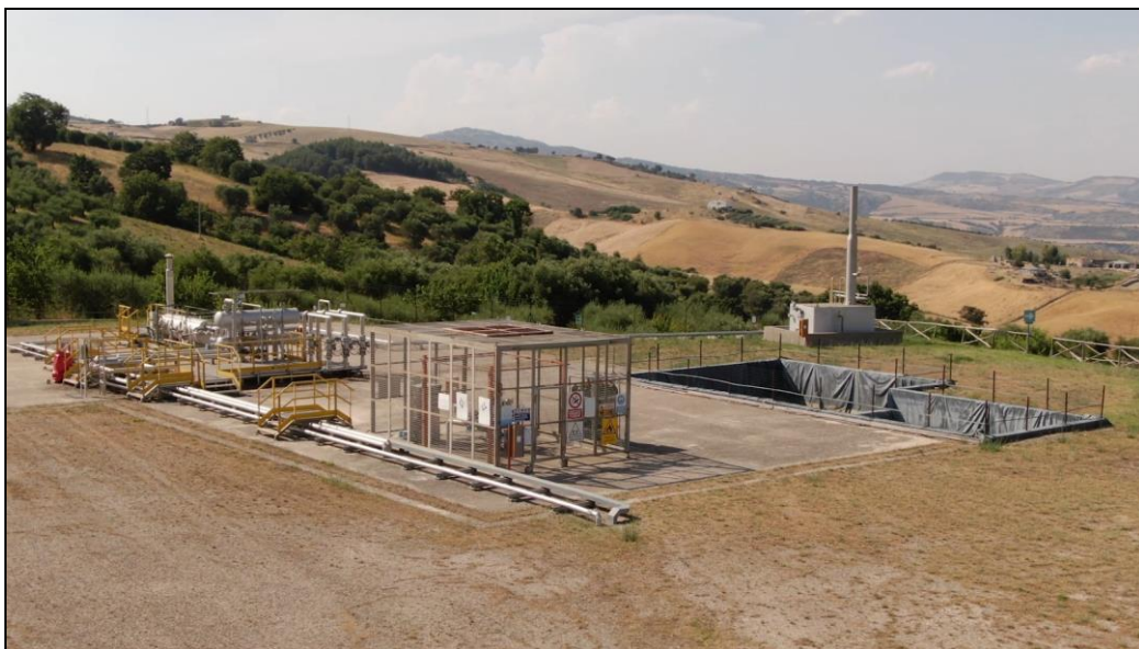
Figura 2 – Vista del piazzale pozzo AC2
