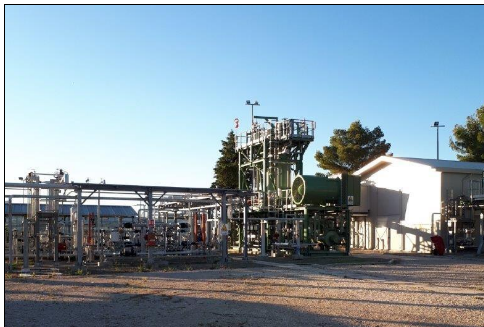
Figura1 – Stralcio della nuova unità di disidratazione Presso la C.le Garaguso
