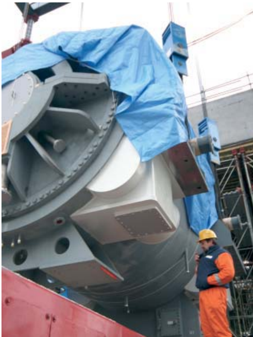
Centrale di Torviscosa: montaggio di una turbina
