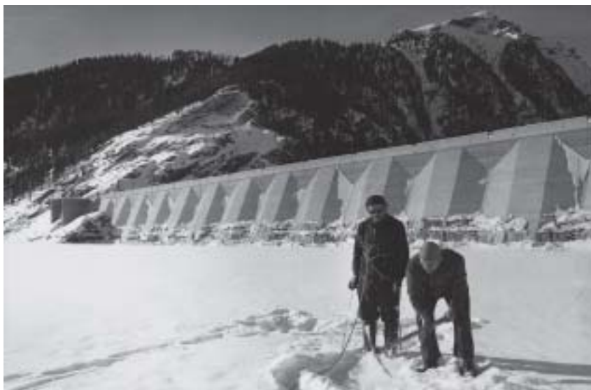
Diga del Gioveretto. Rilevazione dello spessore del ghiaccio (anni '50).
